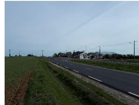
Photo 3 : Fossé le long de la RD 2020
