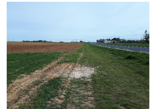
Photo 4 : Absence de fossé le long de la RD 2020
