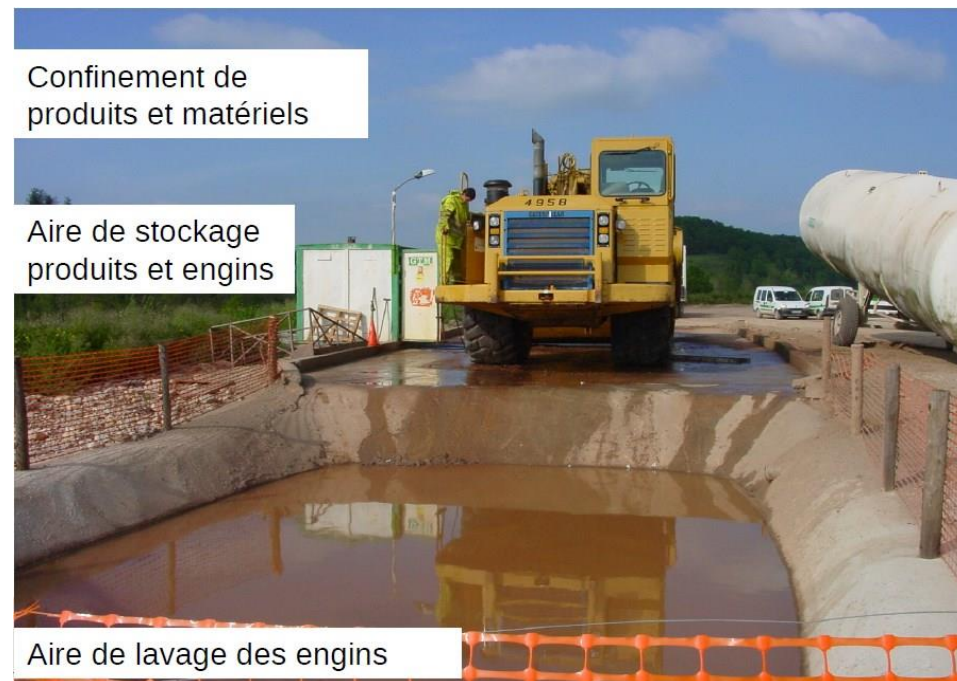
Figure 66 : Exemple d'une aire de chantier avec une fosse de nettoyage
